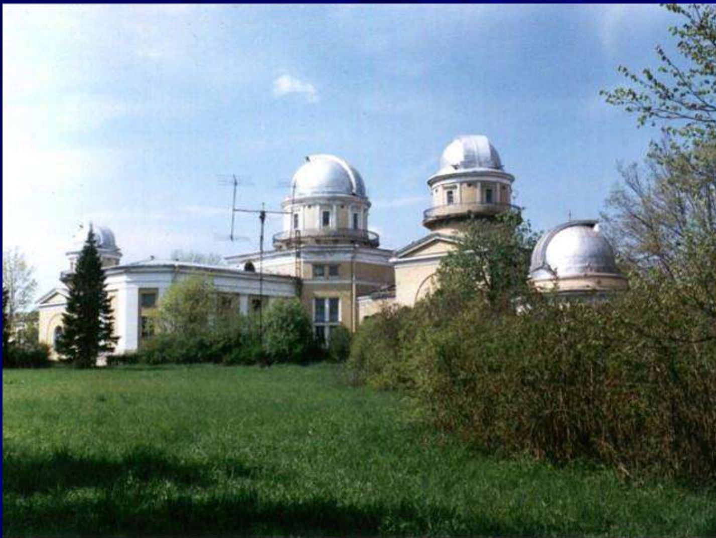
Вид Главного здания ГАО РАН с южной стороны.
