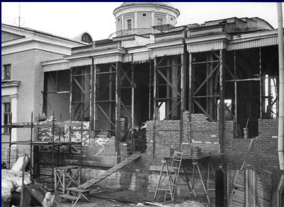
Начало реконструкции Западного меридианного зала, 1998-99 гг.
